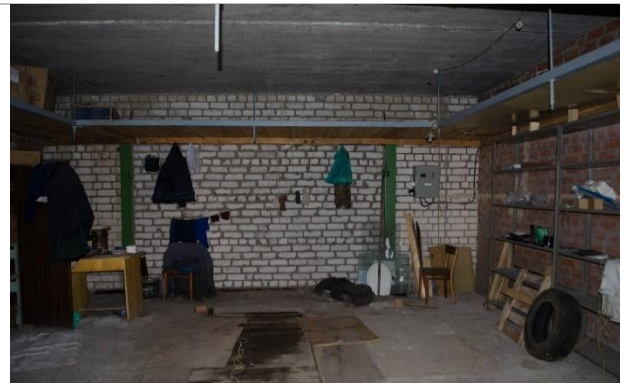
Фотография 3.2. Внутреннее помещение объекта
