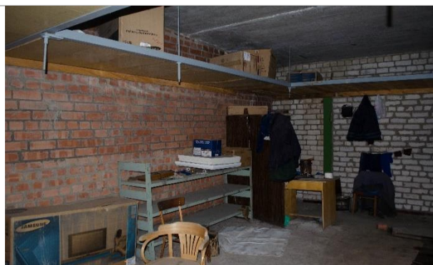
Фотография 3.3. Внутреннее состояние объекта
