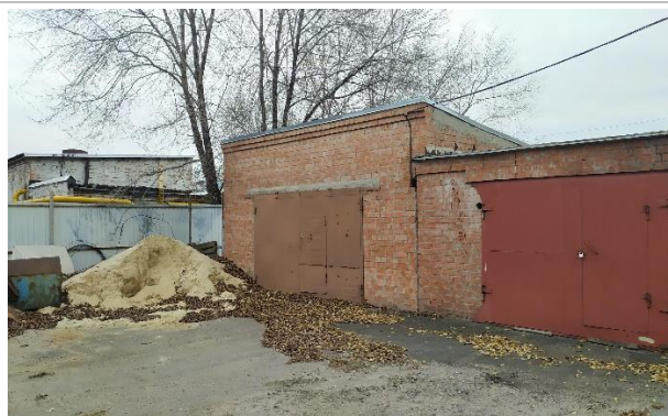
Фотография 3.1. Внешнее состояние объекта
